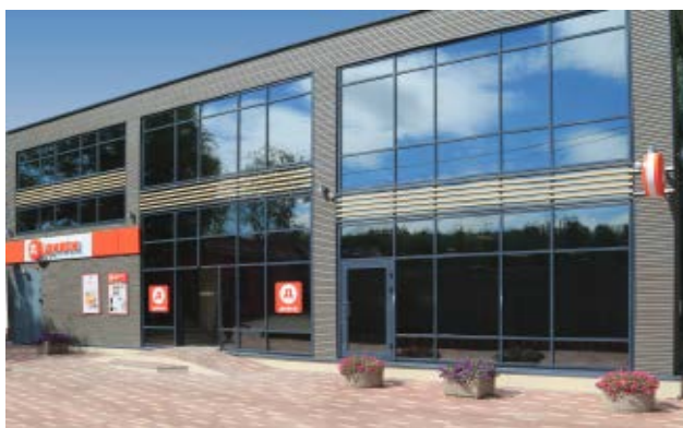
ТЦ в г.Химки (600 м 2 )
