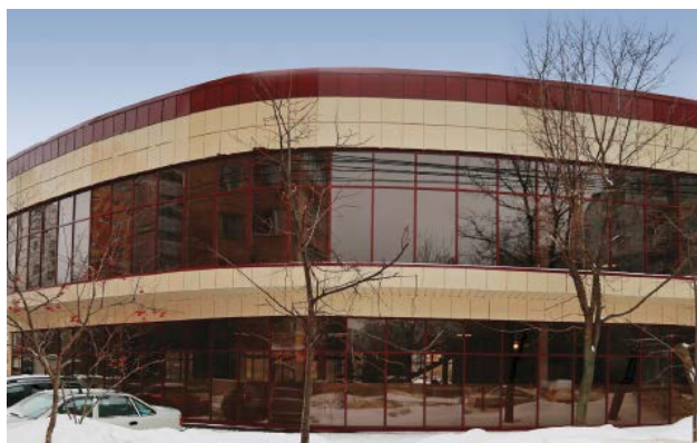
ТЦ в г.Химки (780 м 2 )
