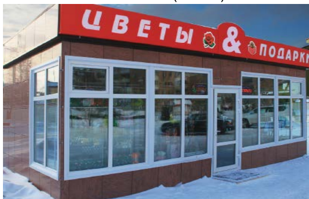
Павильон в г. Лобня (32 м 2 )
