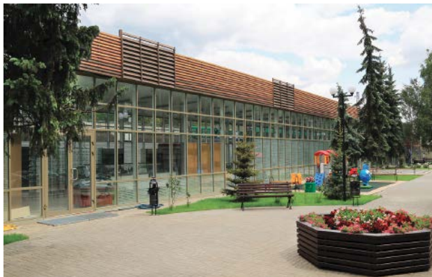
ТЦ в г.Химки (800 м 2 )
